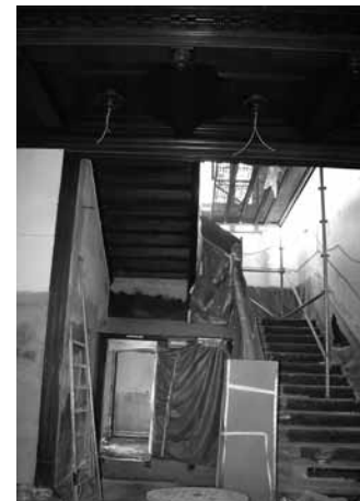
Ohne Gerüst im Treppenhaus sind weder Wandsanierung noch Freilegung der Malereien möglich. ▲
