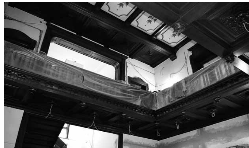
Die alte Farbe wird mit heißem Dampf beseitigt, der Stuckspiegel freigelegt und der Originalzustand wieder hergestellt. ►
