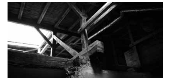
Die Holzbalken des Dachfußbodens mussten wegen Schwamm und Schimmelpilz herausgerissen werden. ▼
