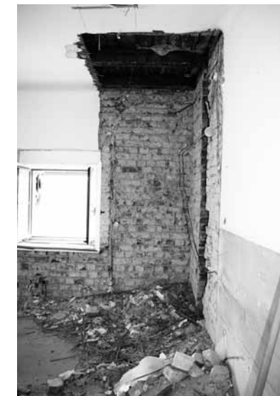
Stellenweise wurden Fußböden und Wände von unten geöffnet, um deren Zustand genau zu prüfen. ▼
