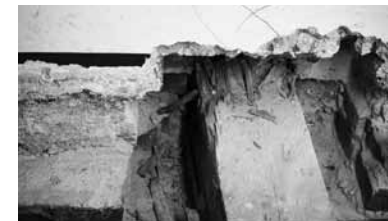
Balkenköpfe sind teilweise gleichfalls von Schwamm und Schimmelpilz befallen. ▼
