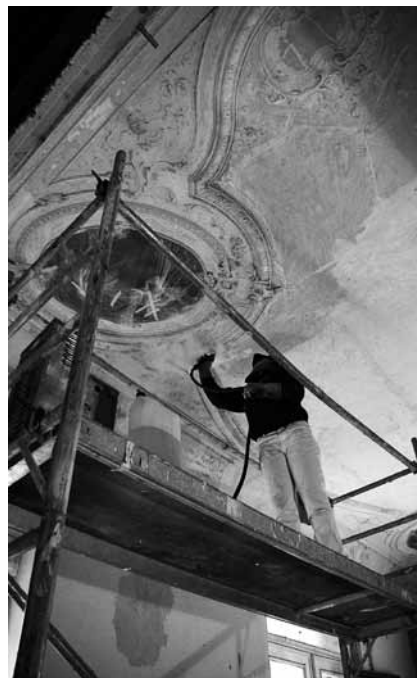
Die alte Farbe wird mit heißem Dampf beseitigt, der Stuckspiegel freigelegt und der Originalzustand wieder hergestellt. ►
