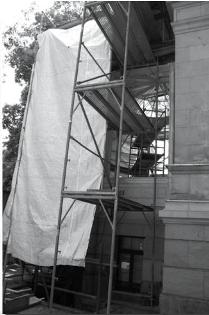
Die Renovierung des Wintergartens am Raum 1.04 wird jedoch noch etwas andauern, da die Instandsetzung sehr kompliziert und kostenintensiv ist.
